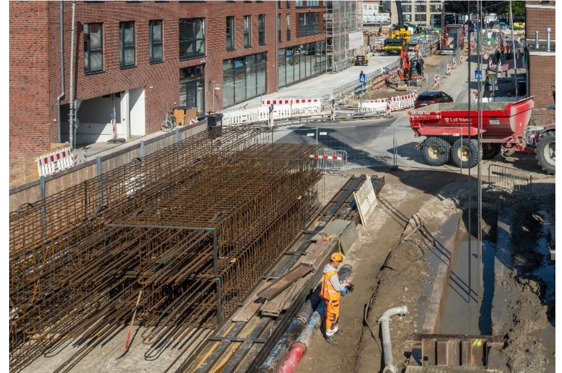
Stahlkörbe an der zukünftigen Haltestelle Bramfeld
