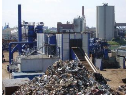
Sortierung und Zerkleinerung
